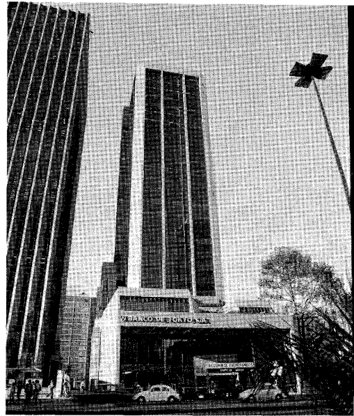
Edifício Asahi オフィスビル 昭和50年9月完成 ▶
